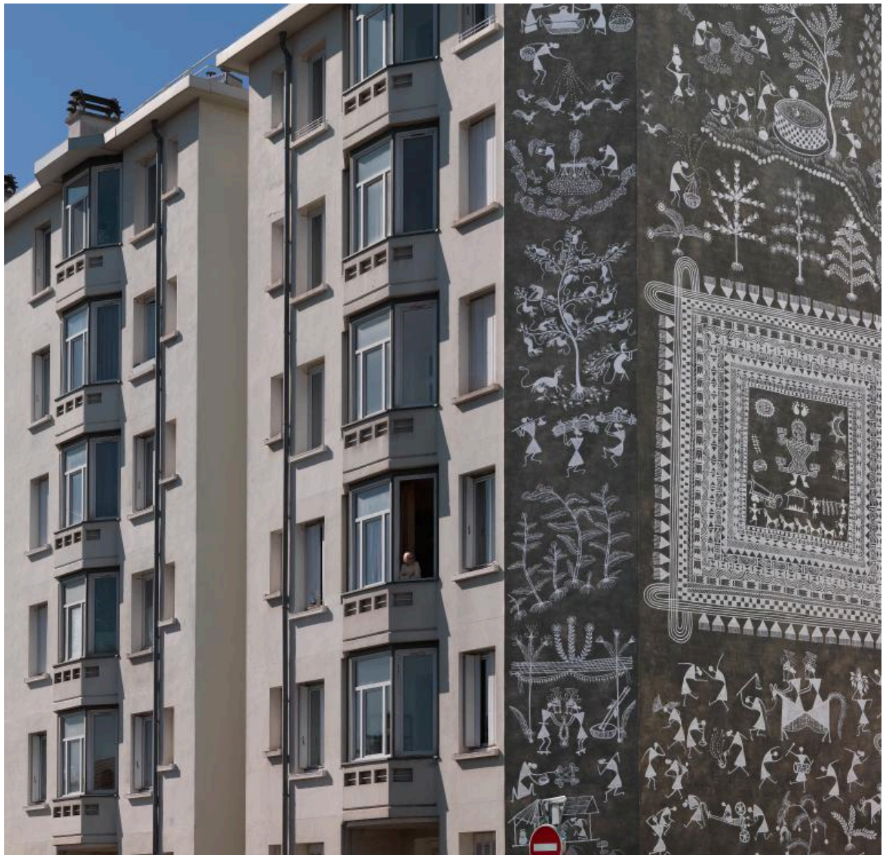
Détail façade avec pignon peint
