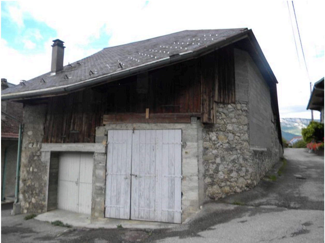
Vue d'une ancienne grange modifiée depuis la place du hameau. (2008 B4 1946).
