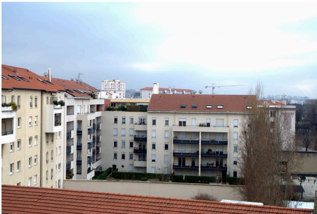
Elévation latérale postérieure, vue d'ensemble depuis l'ouest
