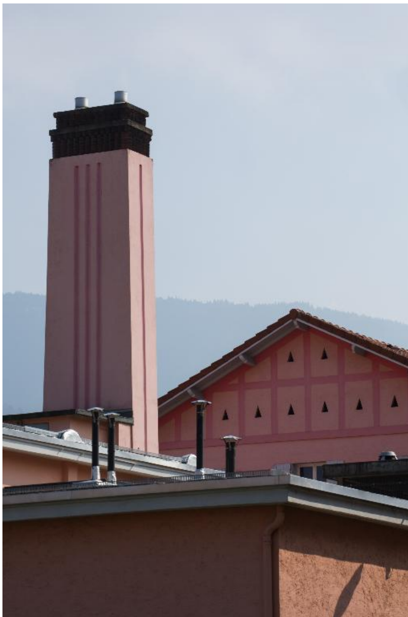
Bât. A : tour cheminée centrale
