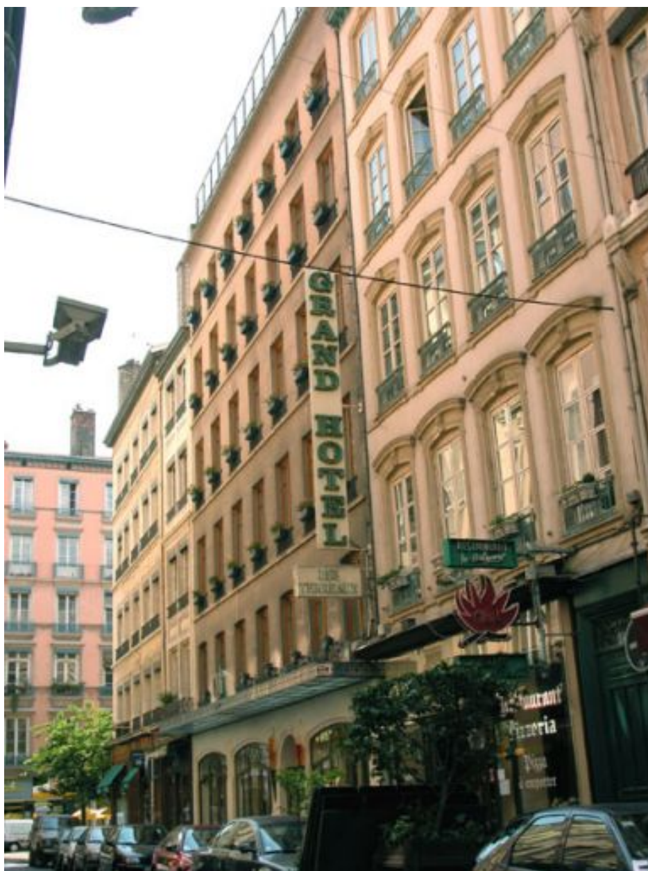
Façade sur rue, vue générale
