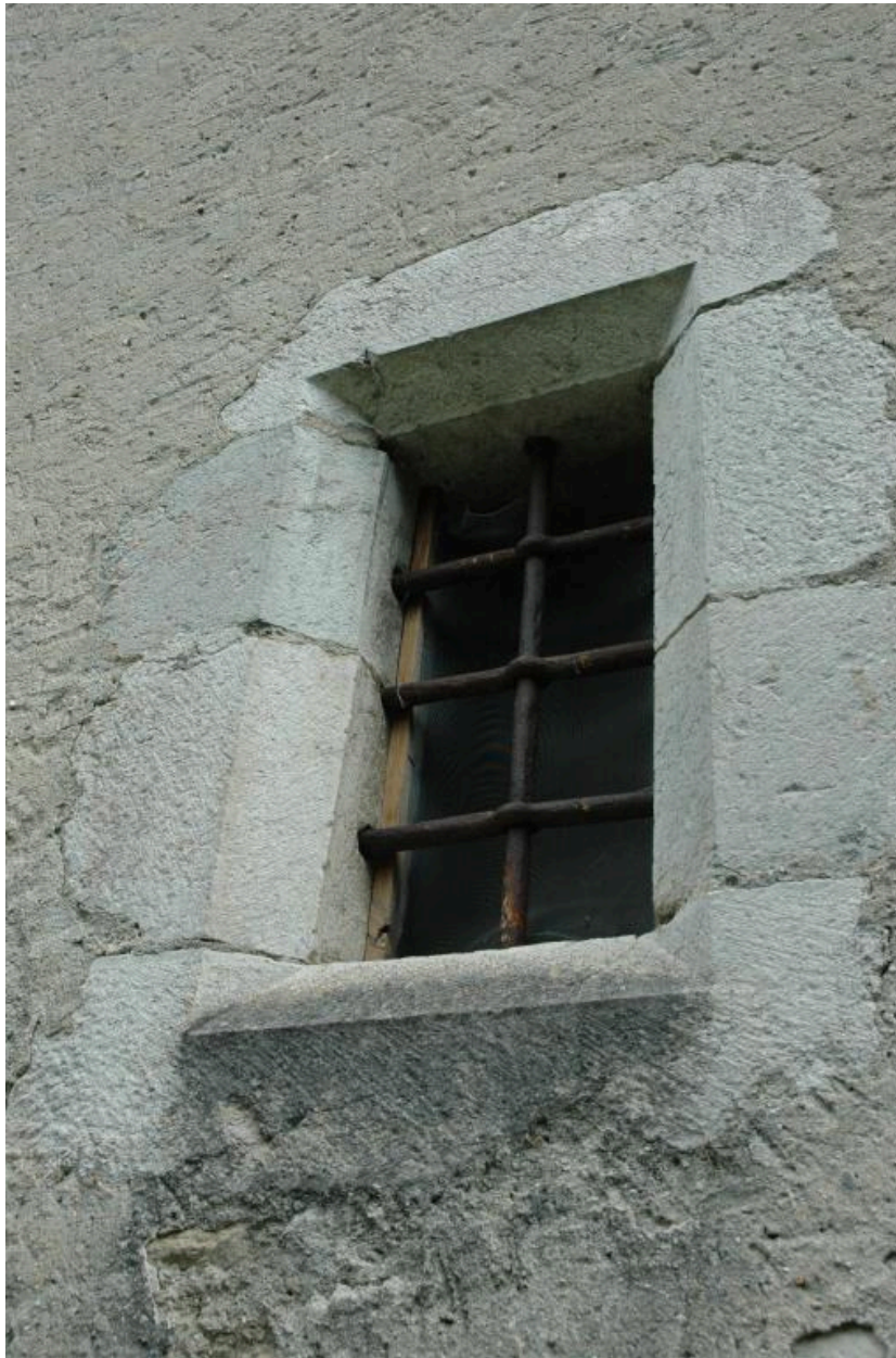
Détail d'une baie chanfreinée de la tour.
