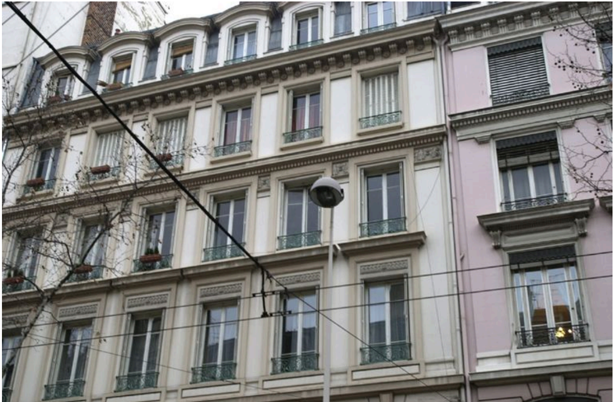
Détail de la façade
