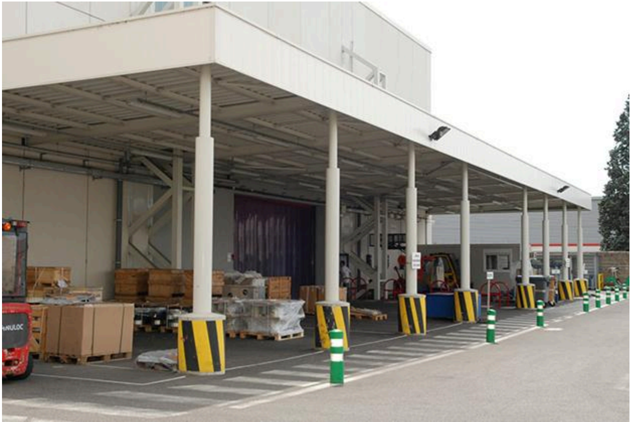
Vue des espaces de stockage
