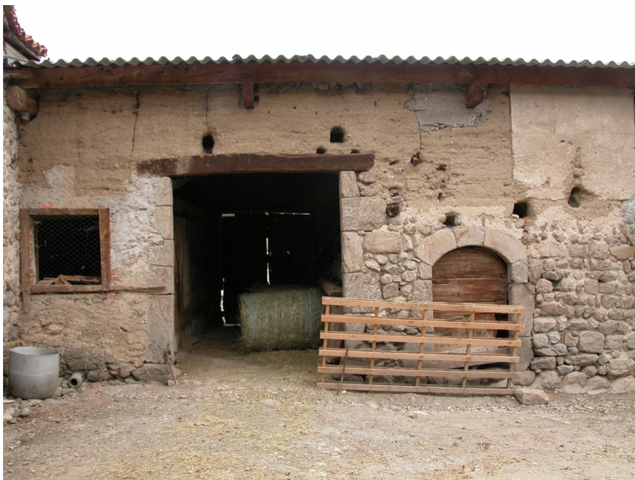
Vue de la seconde remise et du passage couvert nord-ouest, depuis la seconde cour.
