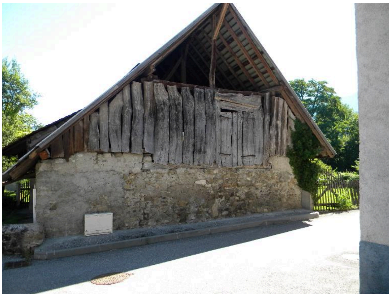
Vue du pignon nord-ouest
