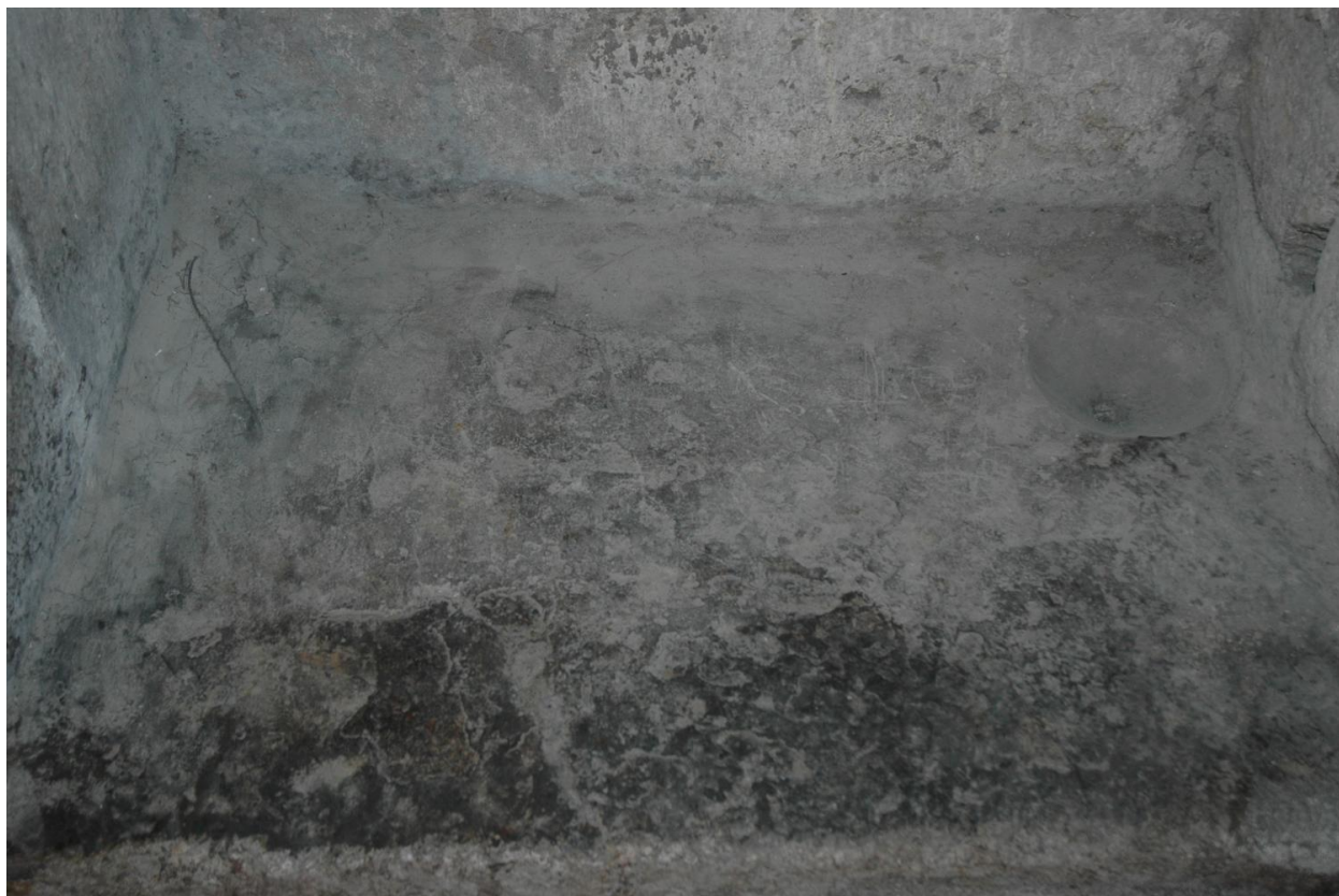
Mur est du choeur, détail du lavabo : écoulement.
