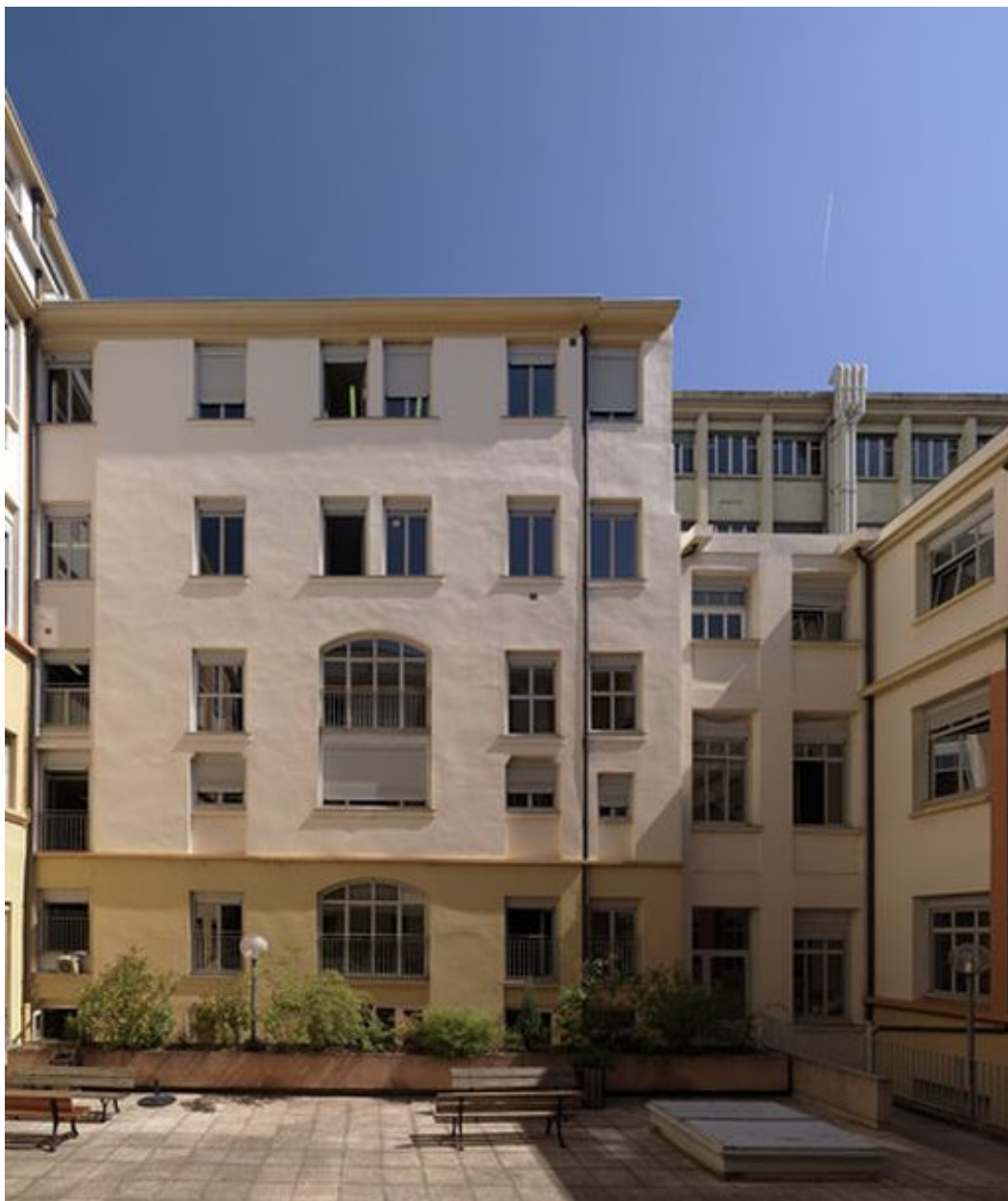
Cour intérieure, élévation latérale nord
