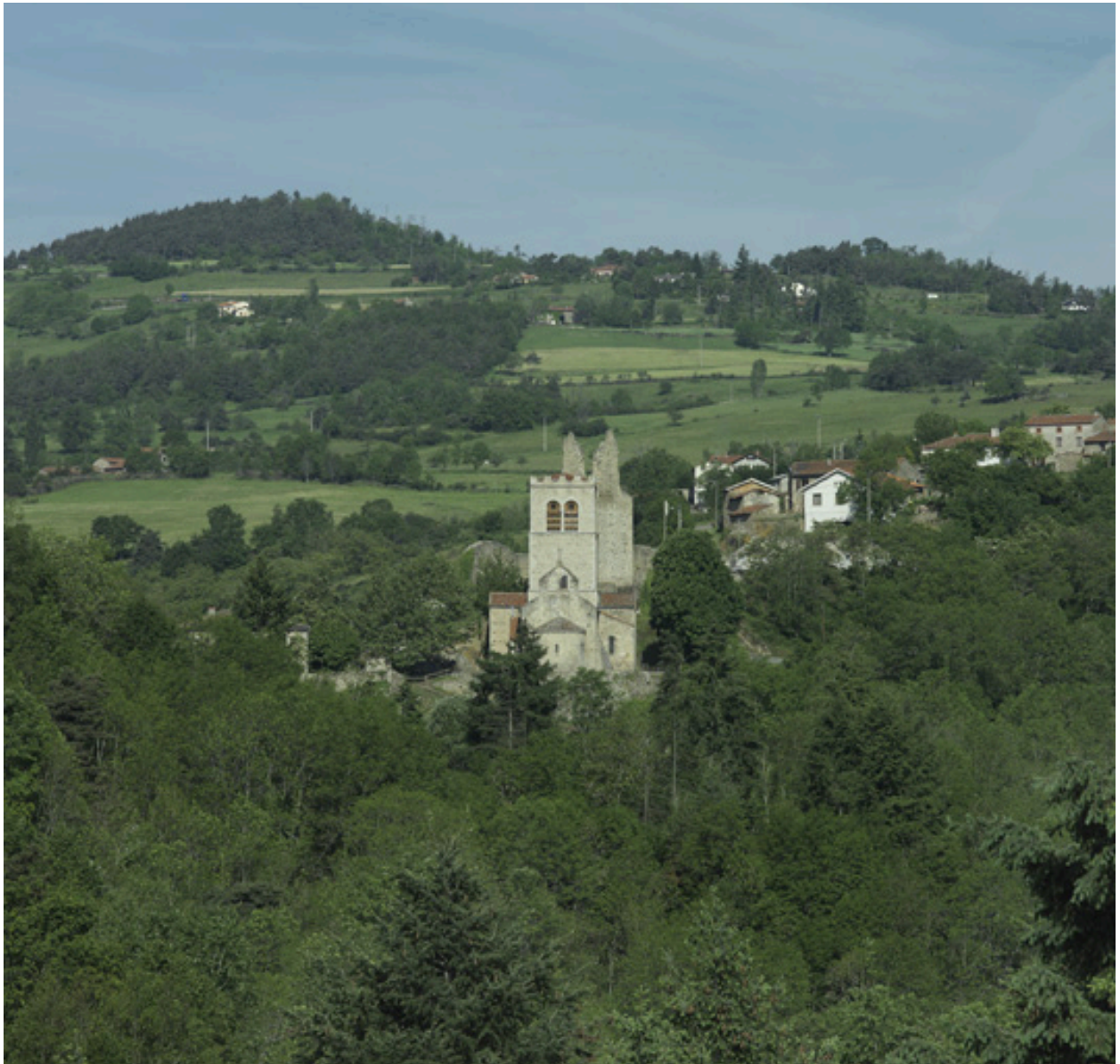
Vue générale du site du château d'Écotay depuis l'est.
