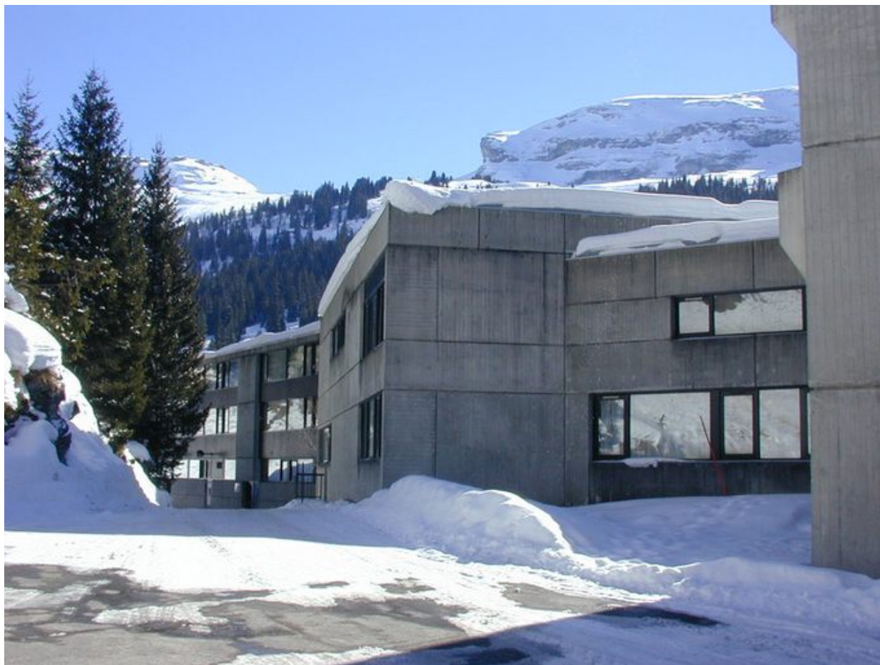
Le bâtiment d'entrée avant réfection. Vue depuis le nord-ouest
