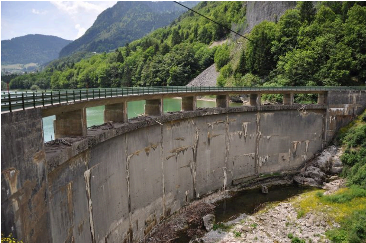
Vue de la crête du barrage du Jotty
