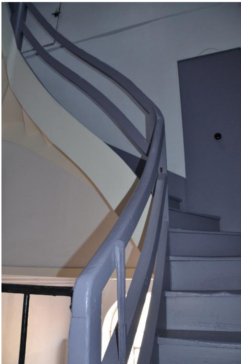
Escalier dernier niveau
