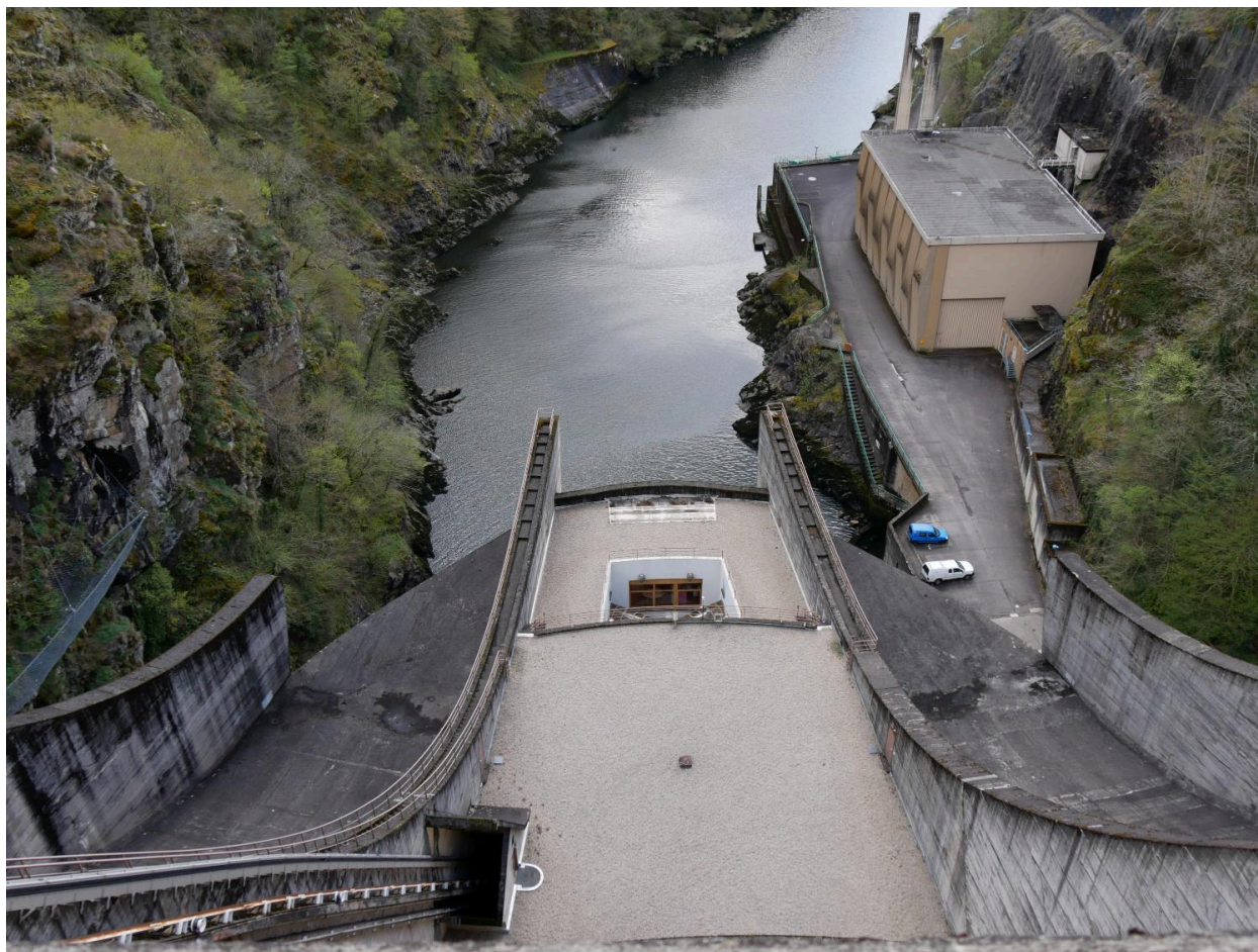
Vue des déversoirs, Dordogne à l'aval du barrage
