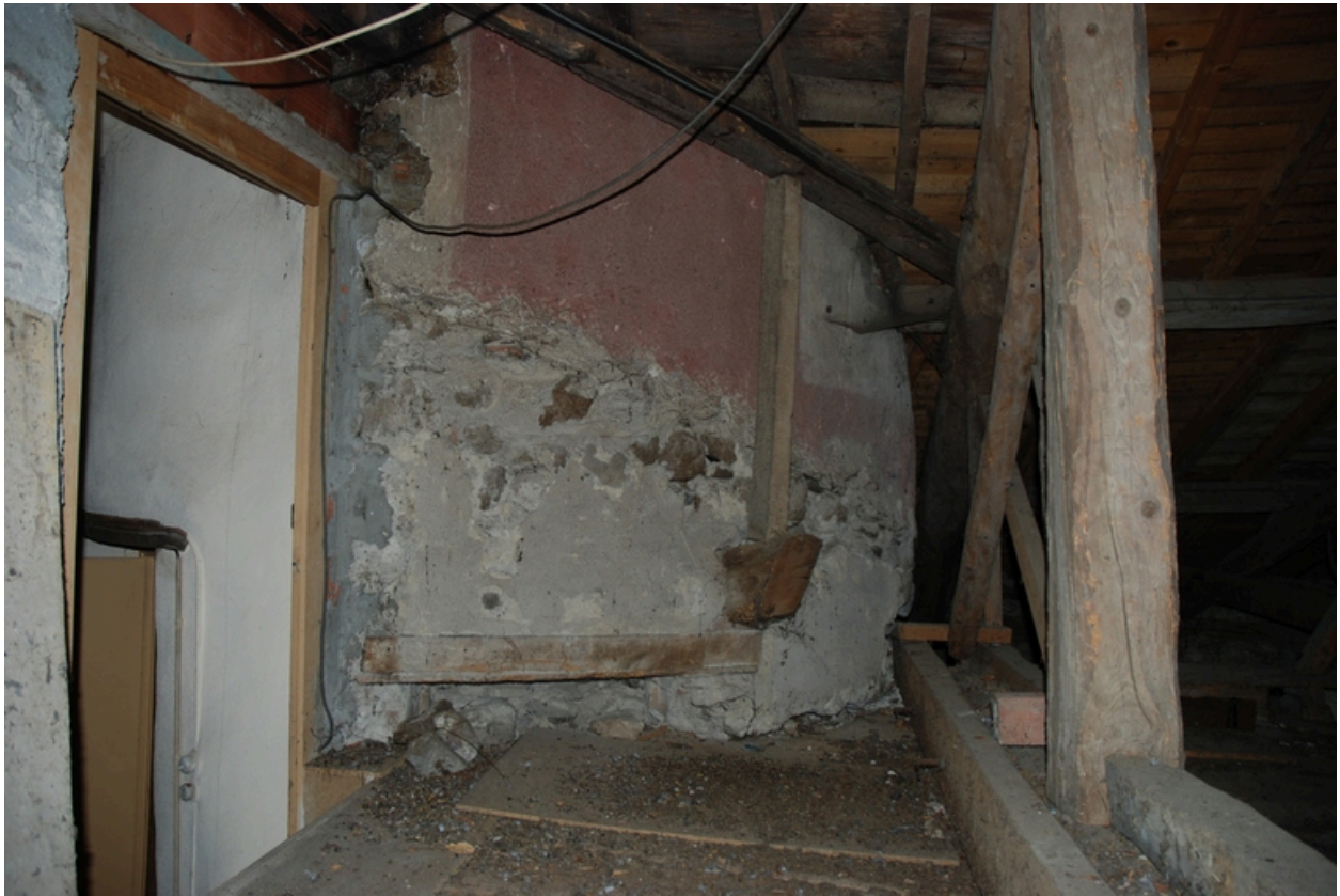
Vue intérieure du comble : charpente.
