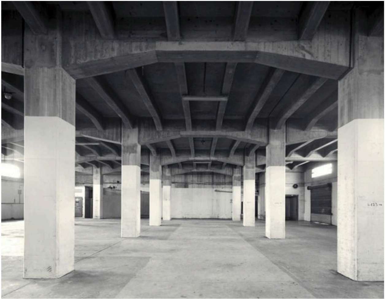
Intérieur du bâtiment de 1960 (bâtiment nord) : travée centrale vers le sud
