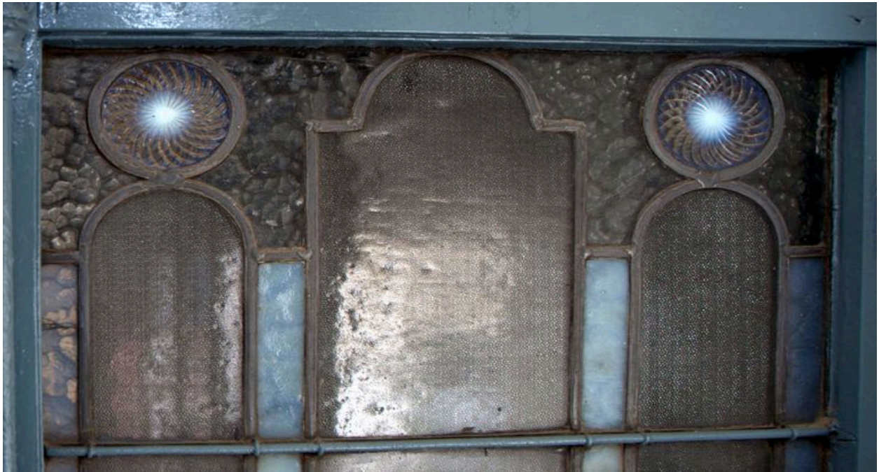
Vitrail de la cage d'escalier, détail d'un panneau depuis l'extérieur
