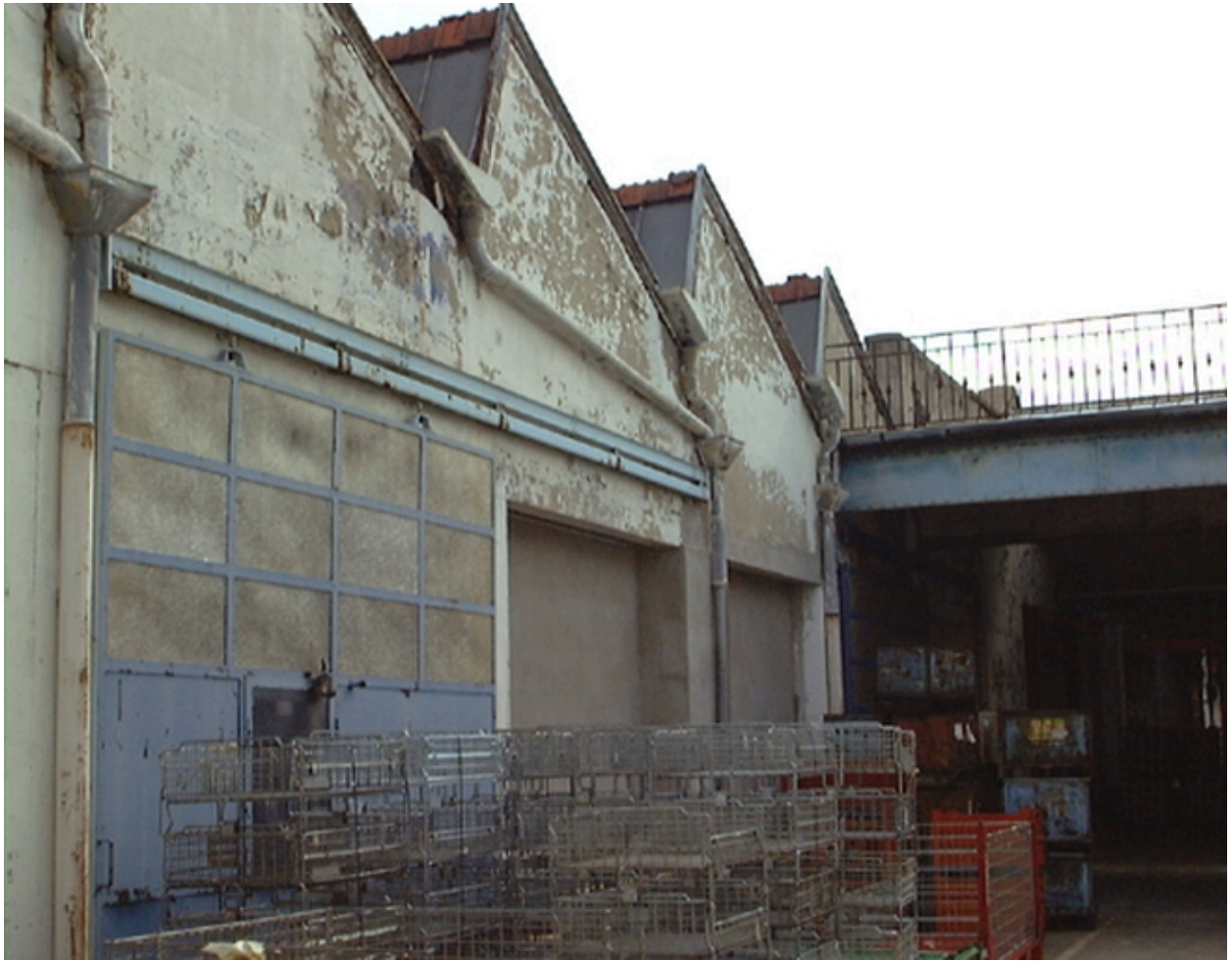
Quai de chargement
