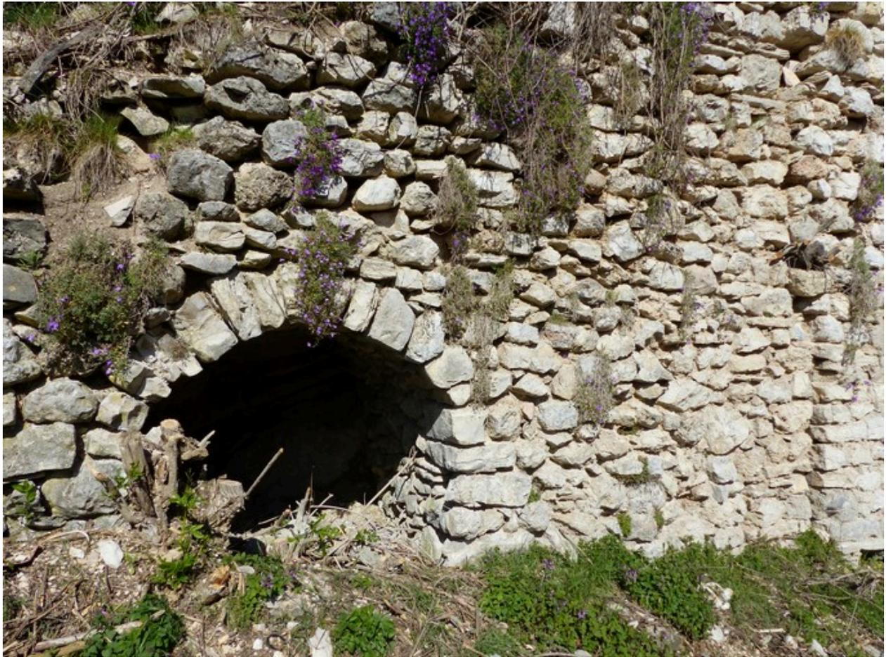
Mur de soutènement d'une maison au village, avec un réduit sous voûte en berceau.
