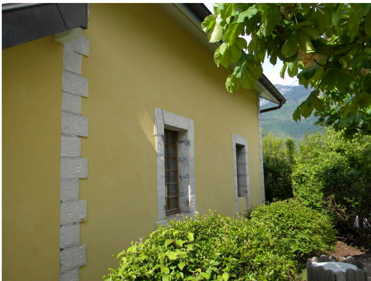
Vue de la façade arrière.
