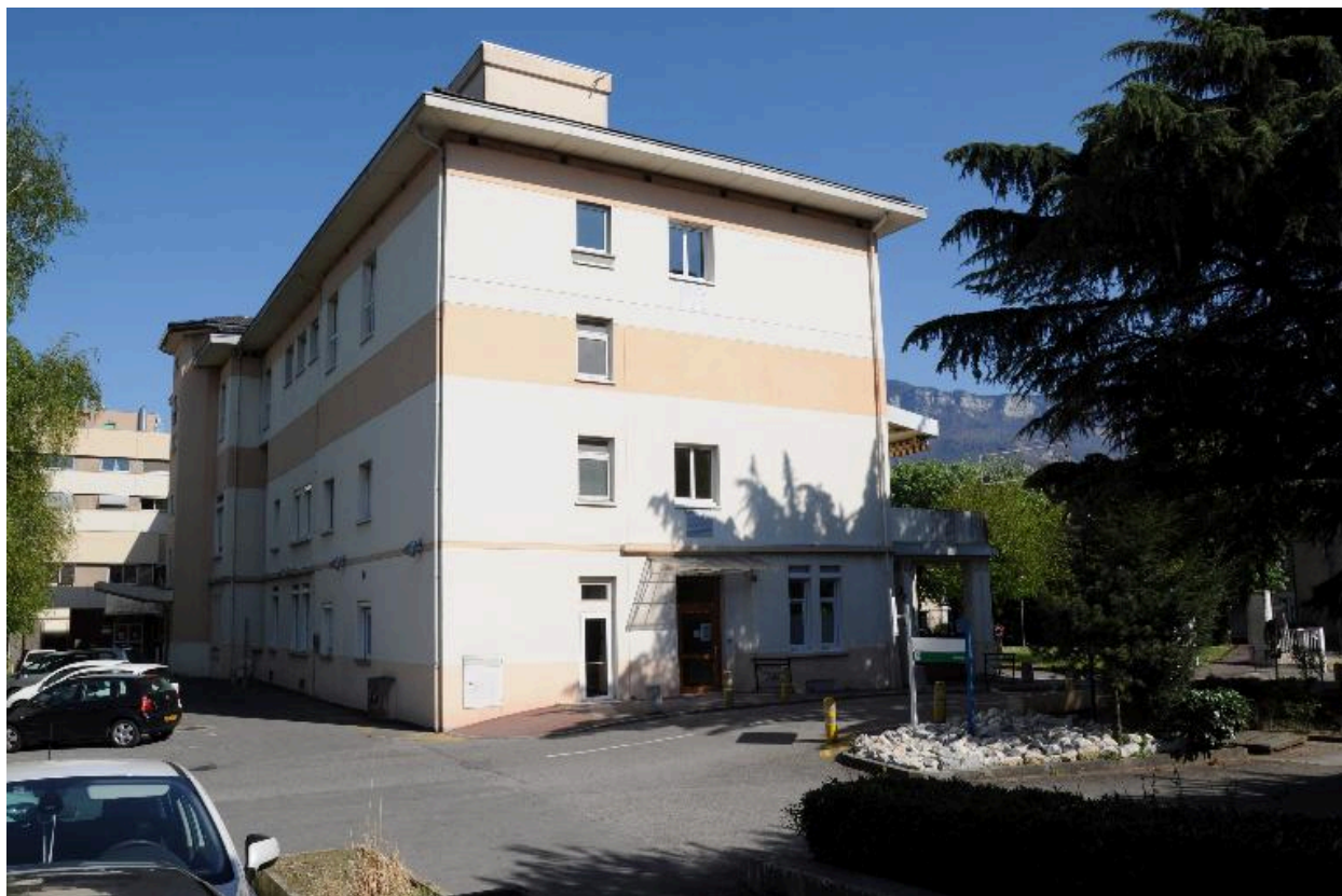
Façades postérieure et latérale
