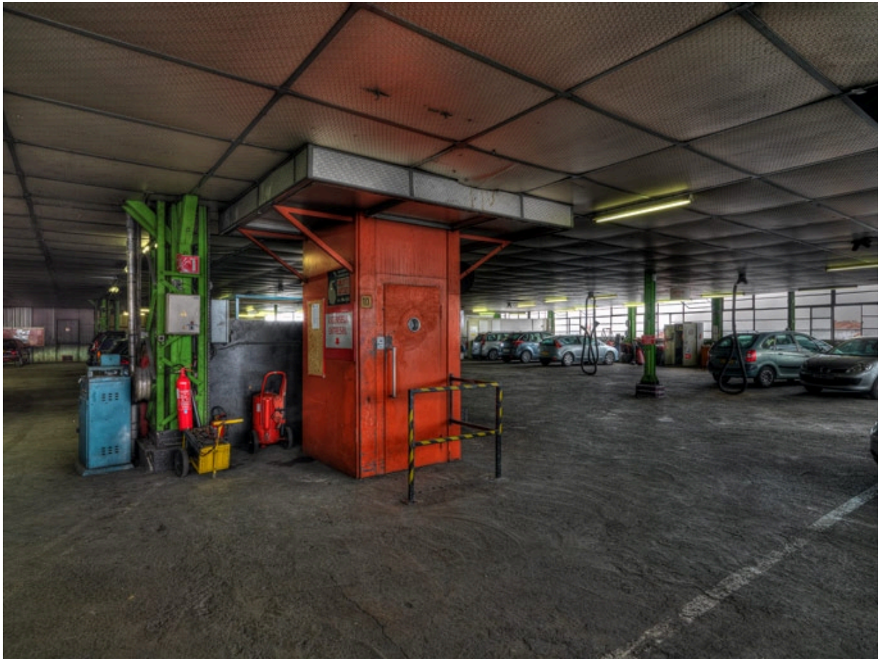
Vue d'ensemble du 4e étage
