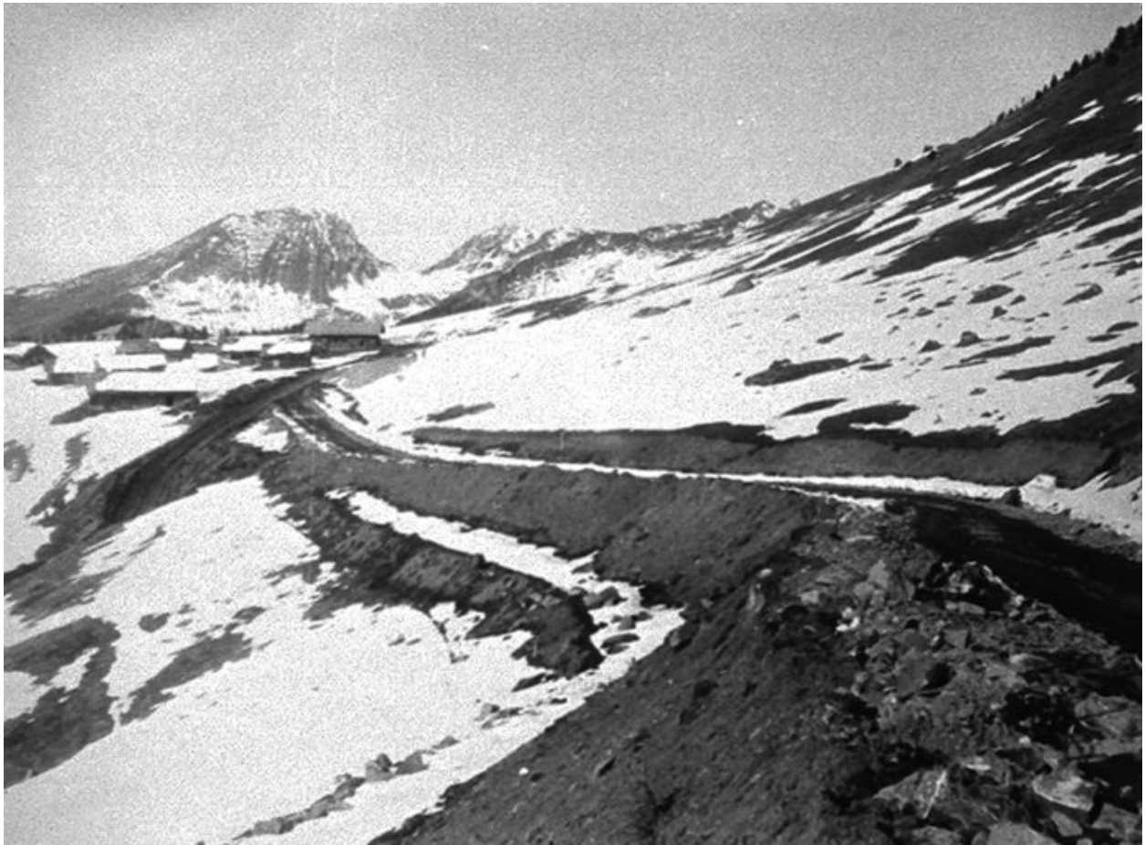
Chantier de la route depuis les chalets d'alpage vers le col d'Avoriaz, 1958-1961
