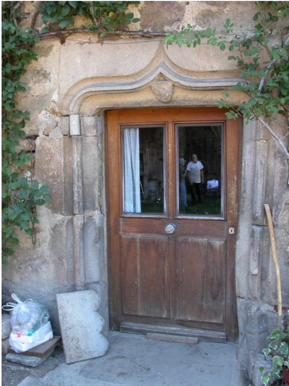
Logis du château, porte d'entrée.
