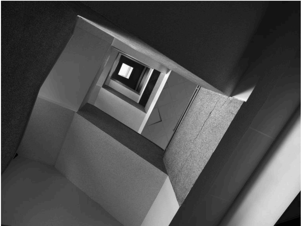
Escalier principal, vue de la cage
