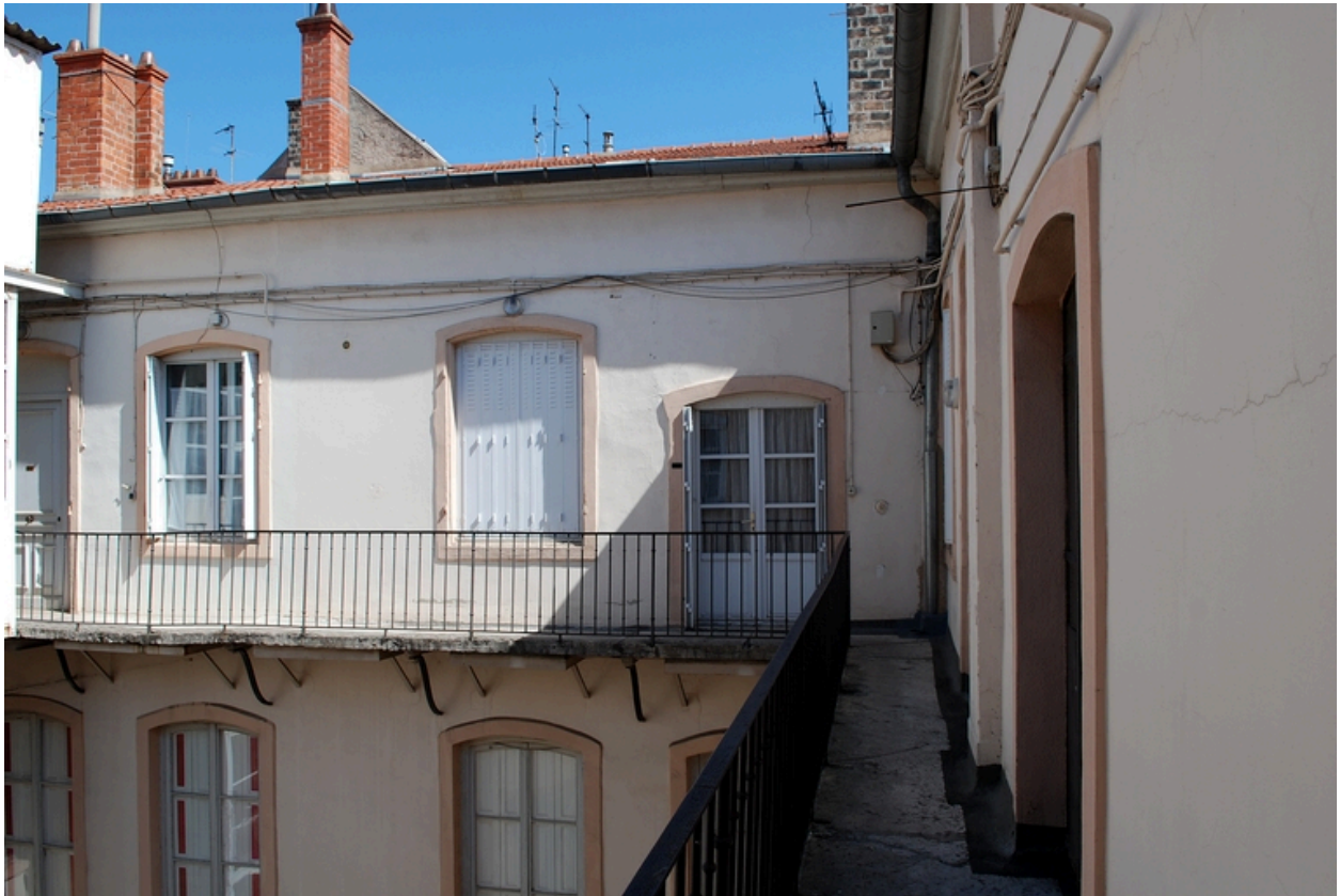
La cour : élévation nord, la coursière au dernier étage
