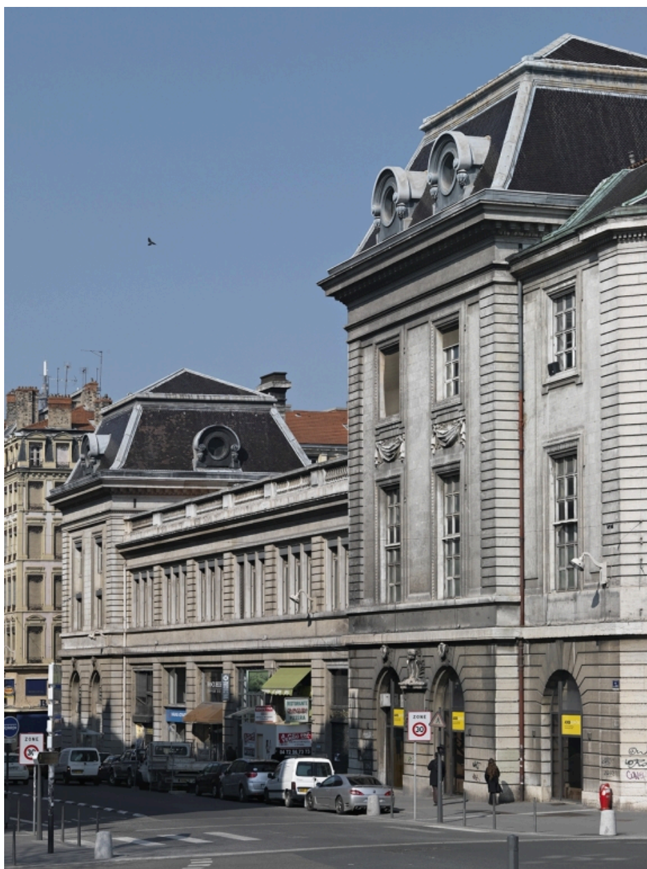
Bâtiments A et A'. Façade sud
