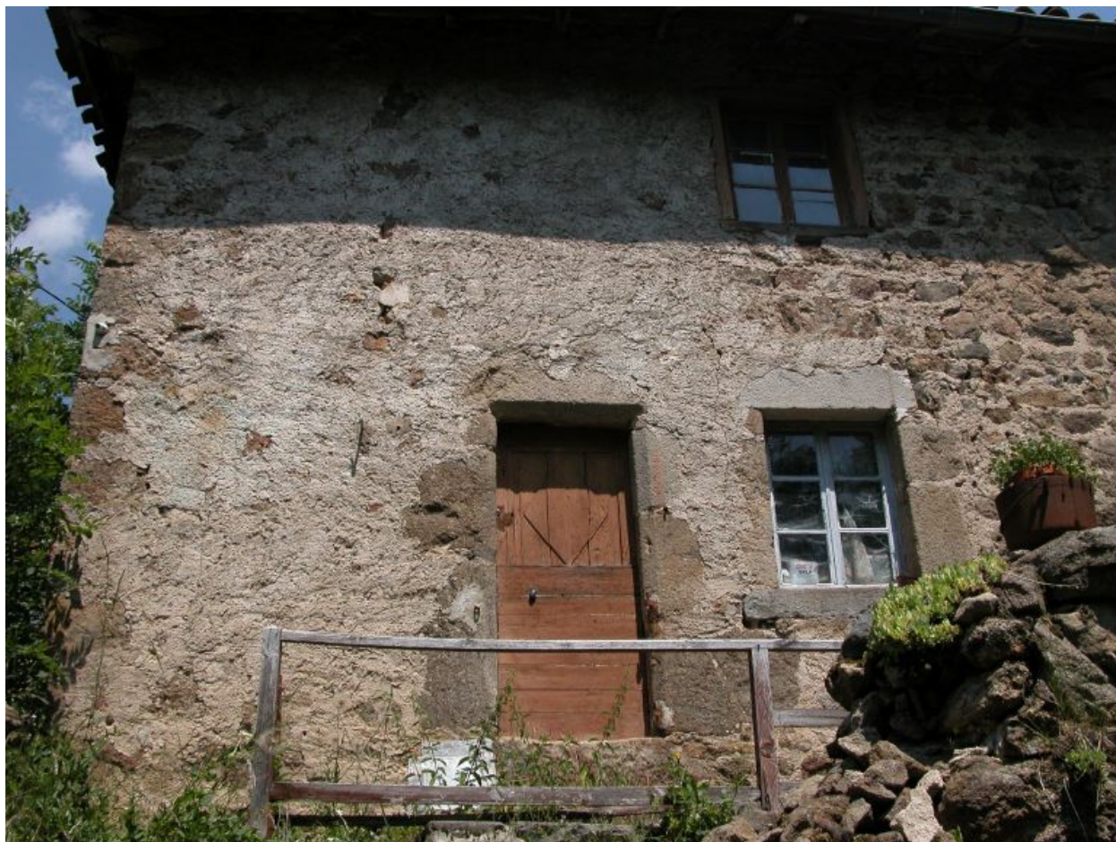
Vue d'ensemble de la façade du premier logis.
