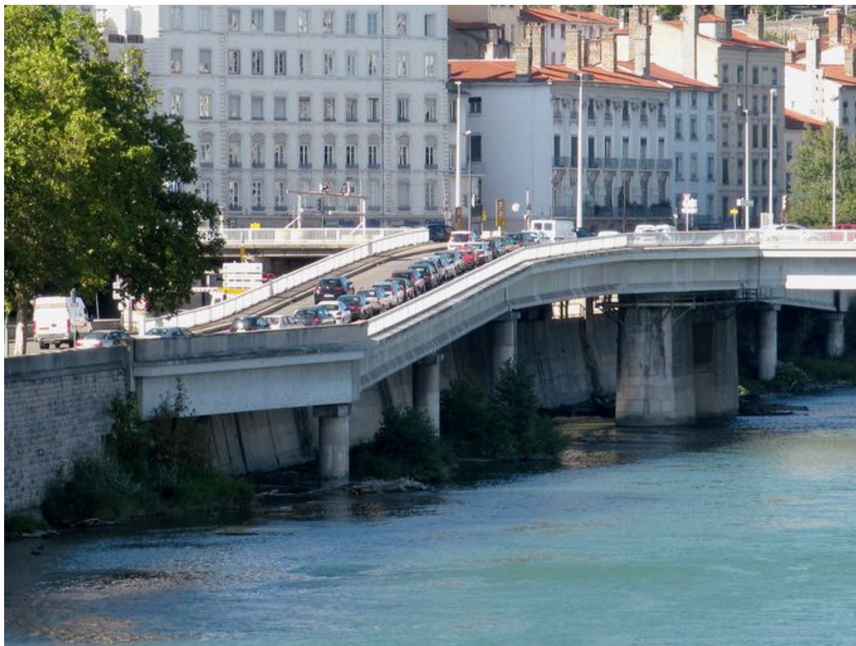
Vue partielle, culée droite, face aval (depuis le pont Morand)
