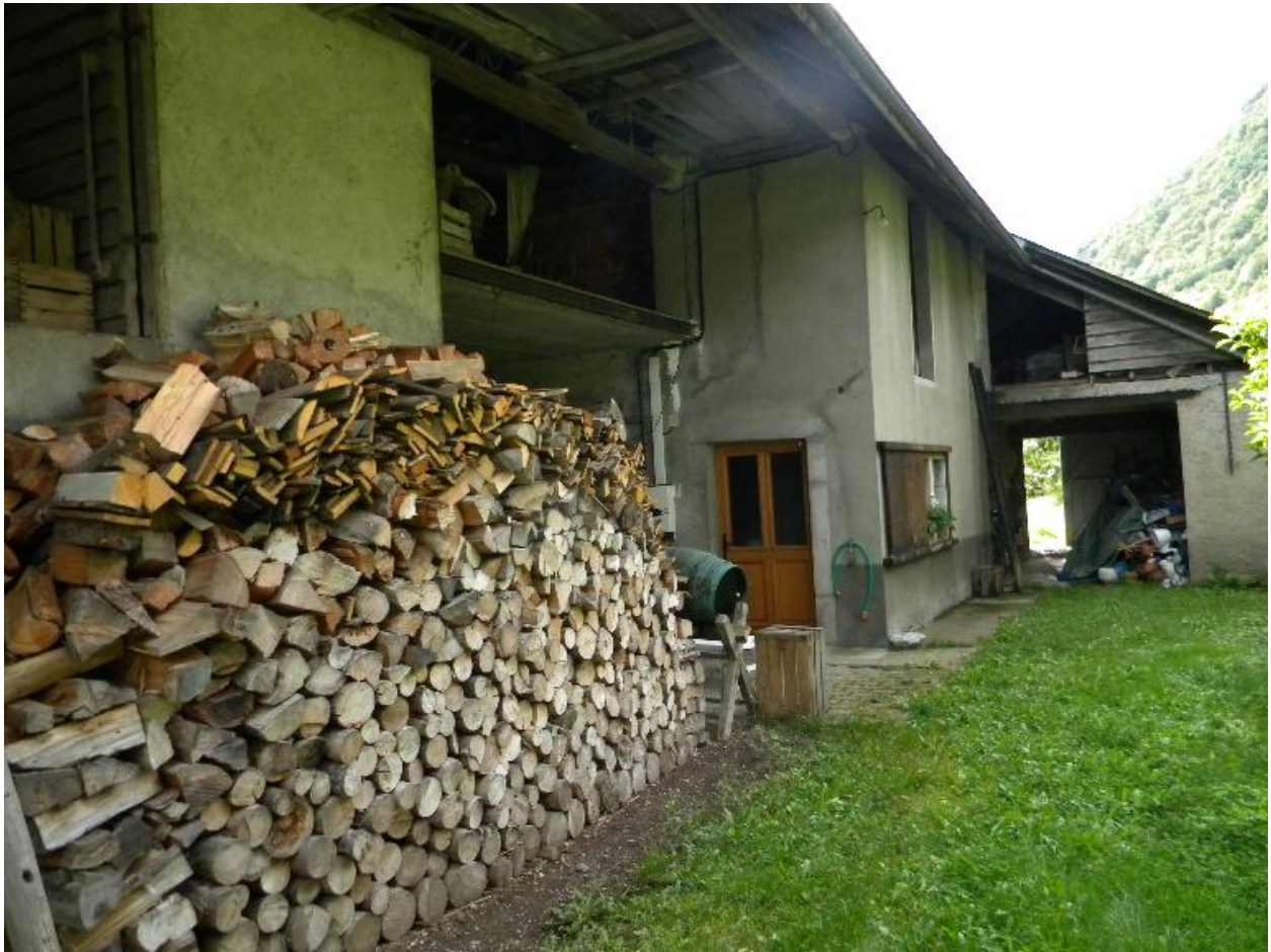
Façade ouest du bâtiment agricole lié au moulin.
