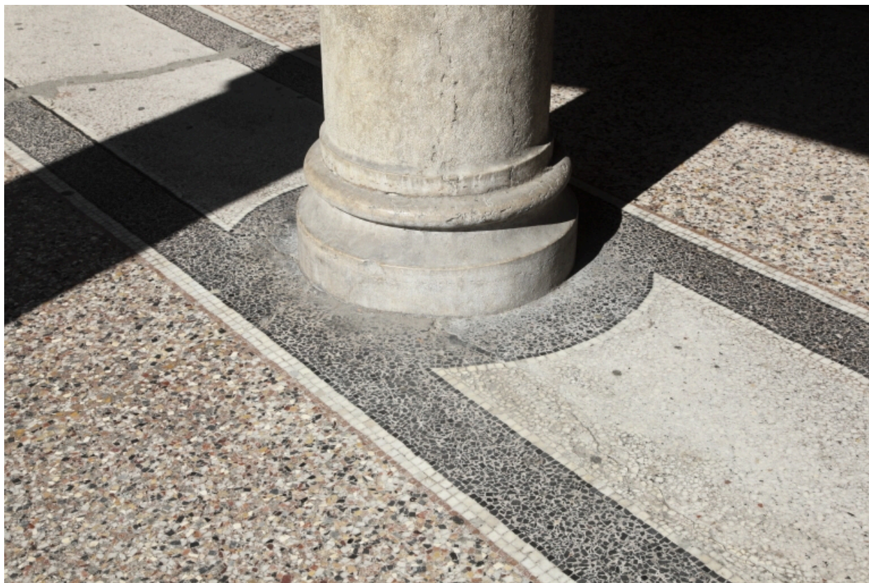
Cour H. Détail d'un chapiteau.
