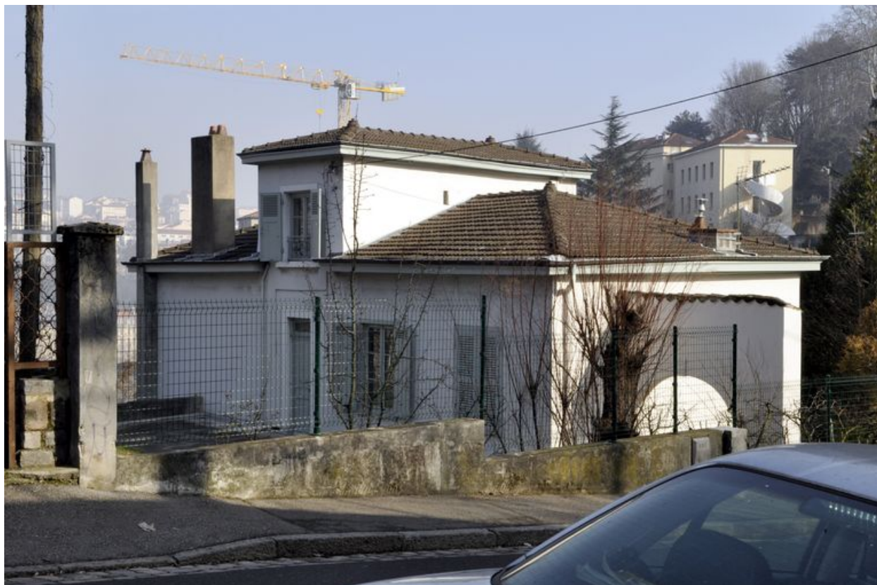
Vue de la façade nord
