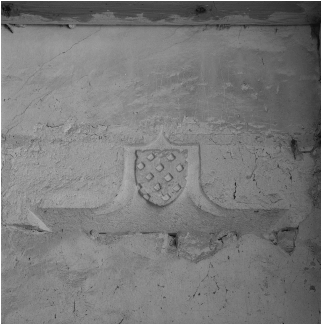
2e étage, baie murée : linteau en accolade avec blason.
