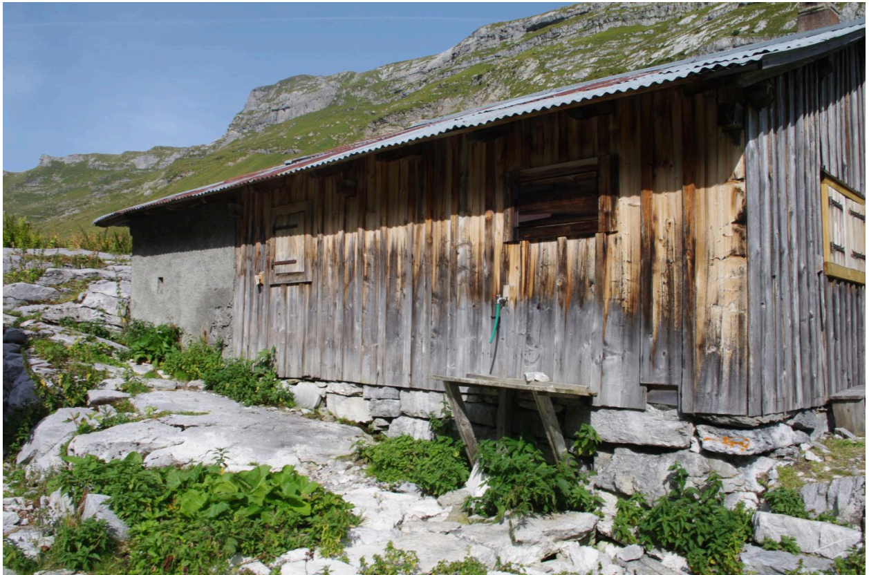
Vue de la façade postérieure ouest
