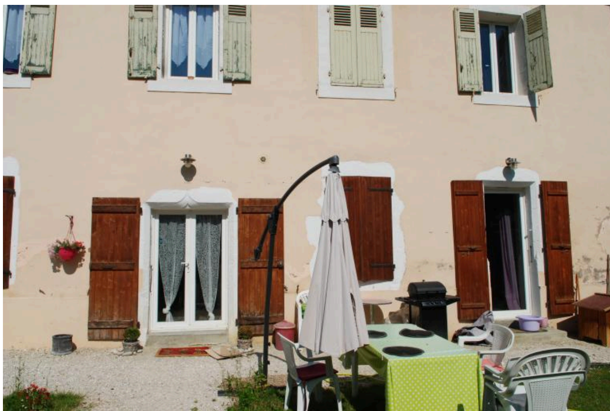
Façade est, détail.
