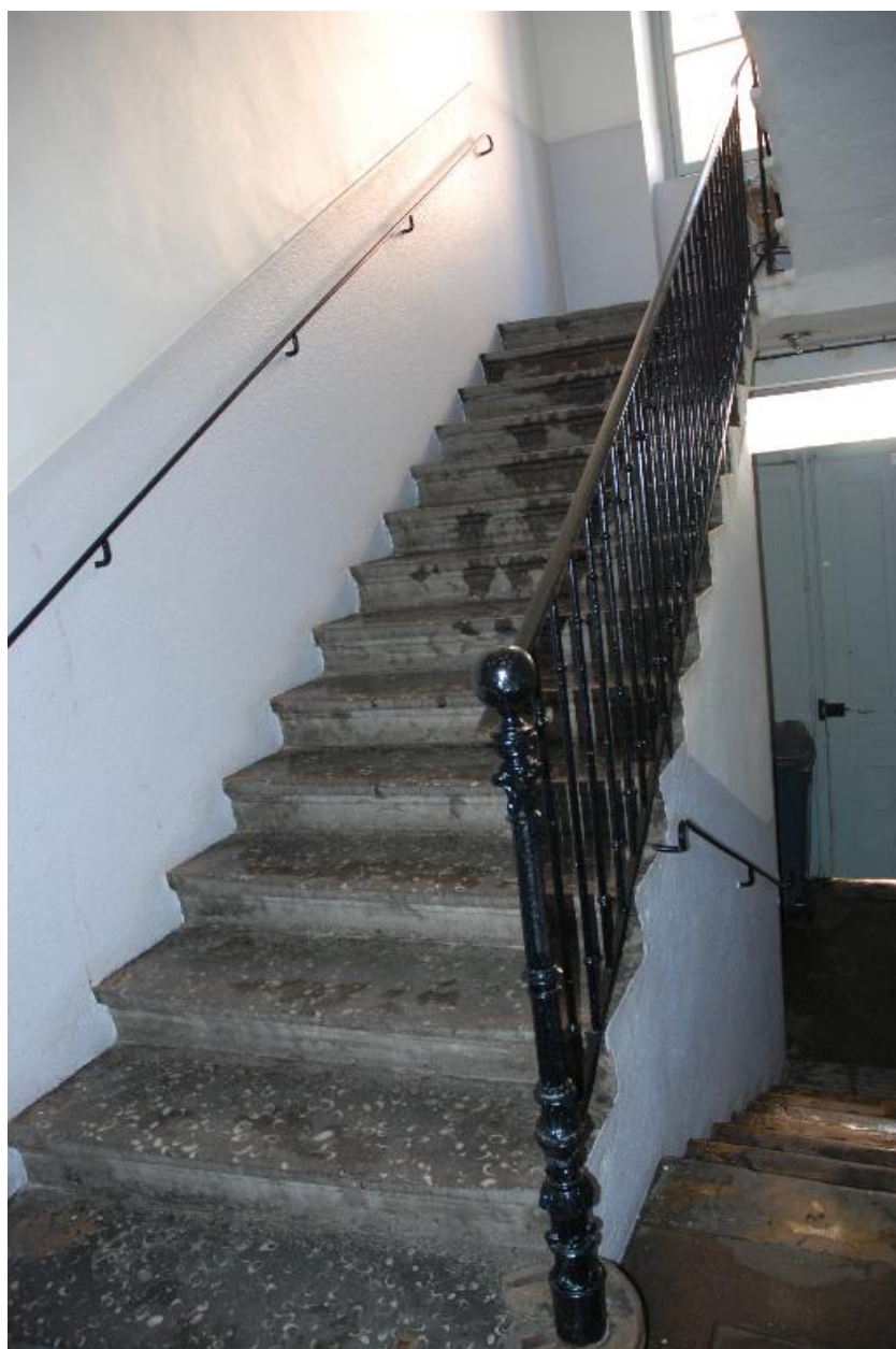
Vue de l'escalier rue d'Ivry
