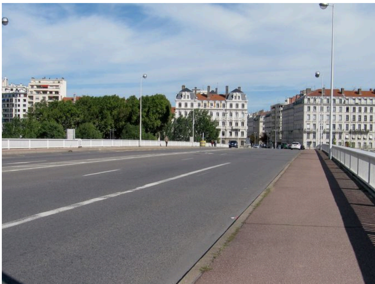
Vue générale, de dessus, chaussée (depuis la rive droite)
