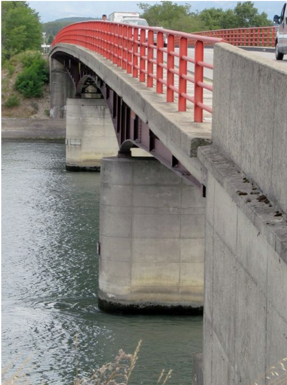
Vue générale, de dessus, face amont, parapet et tablier (depuis la rive droite)
