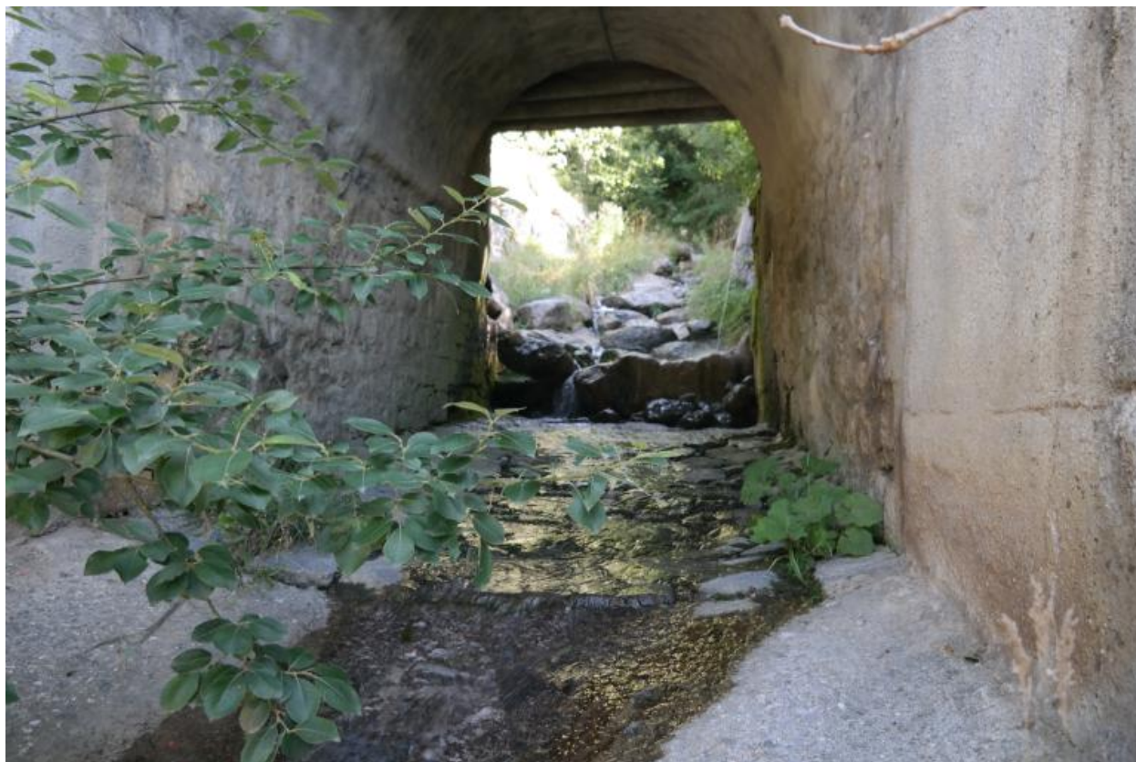
Pont de Fiolle, vue de dessous
