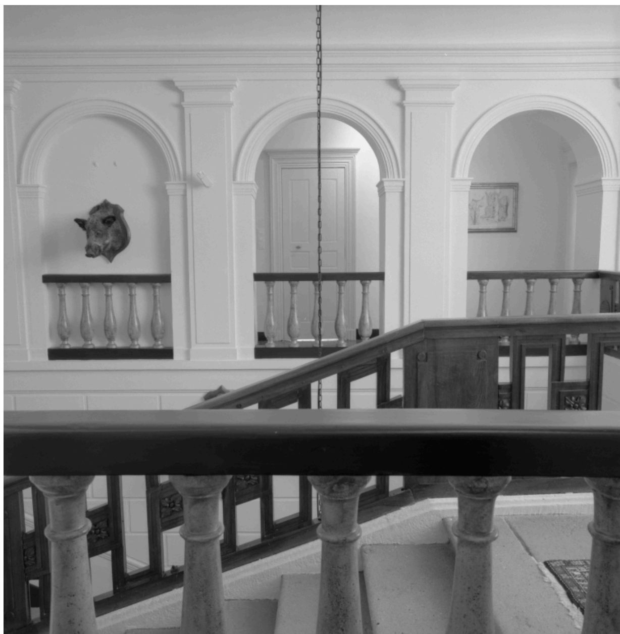
Premier étage : vue du portique nord depuis le portique sud.
