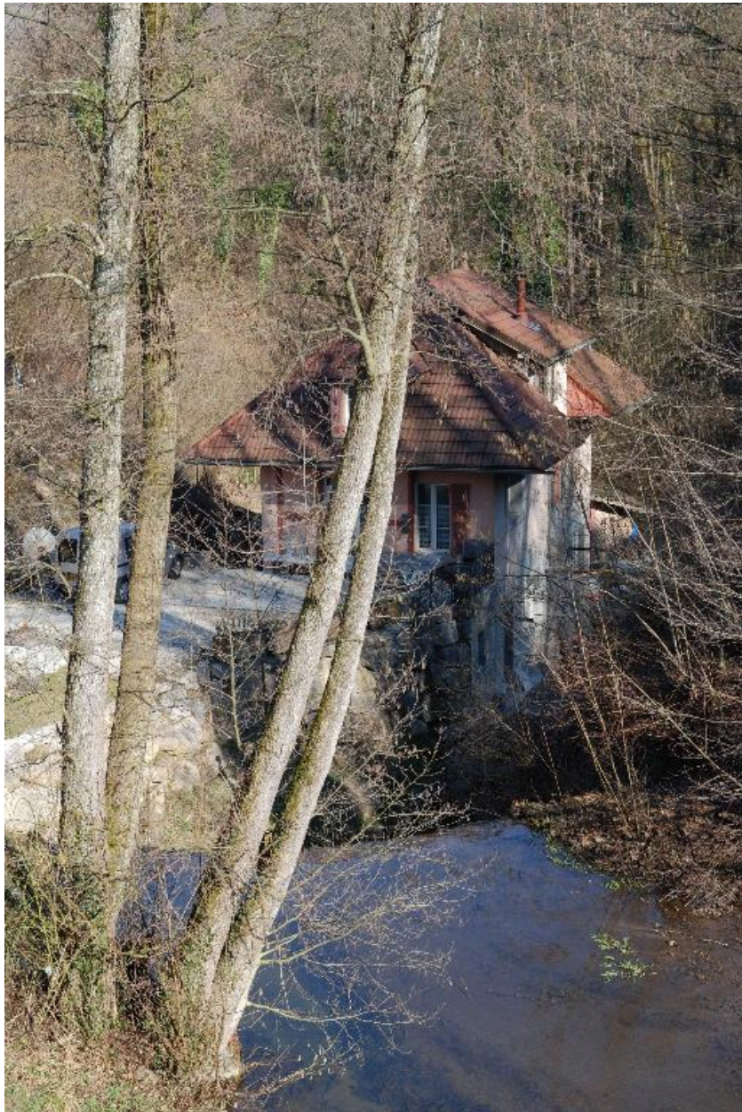
Vue d'ensemble des moulins et de la retenue d'eau.
