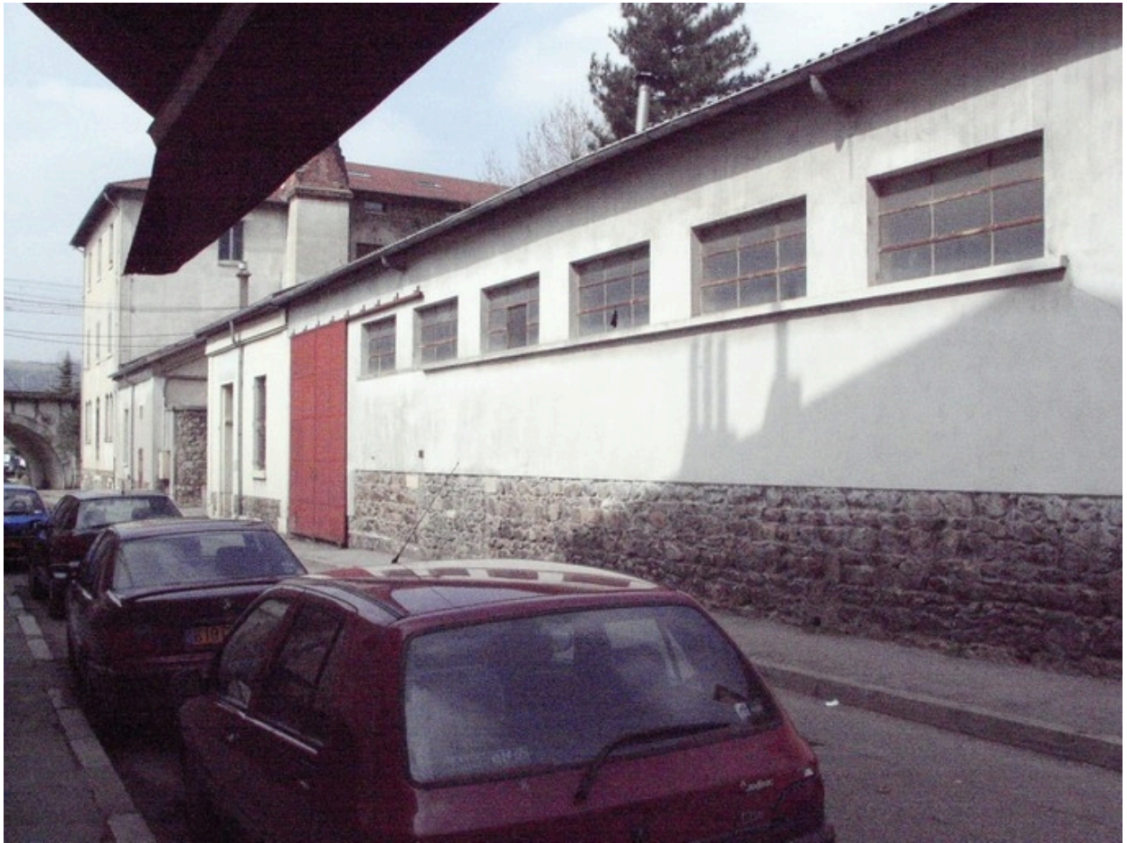
façade sud parcelle 299
