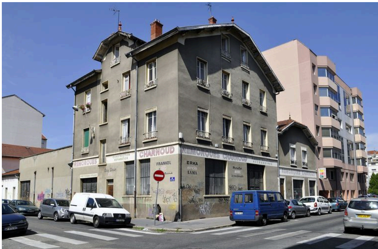
Façade principale et façade latérale
