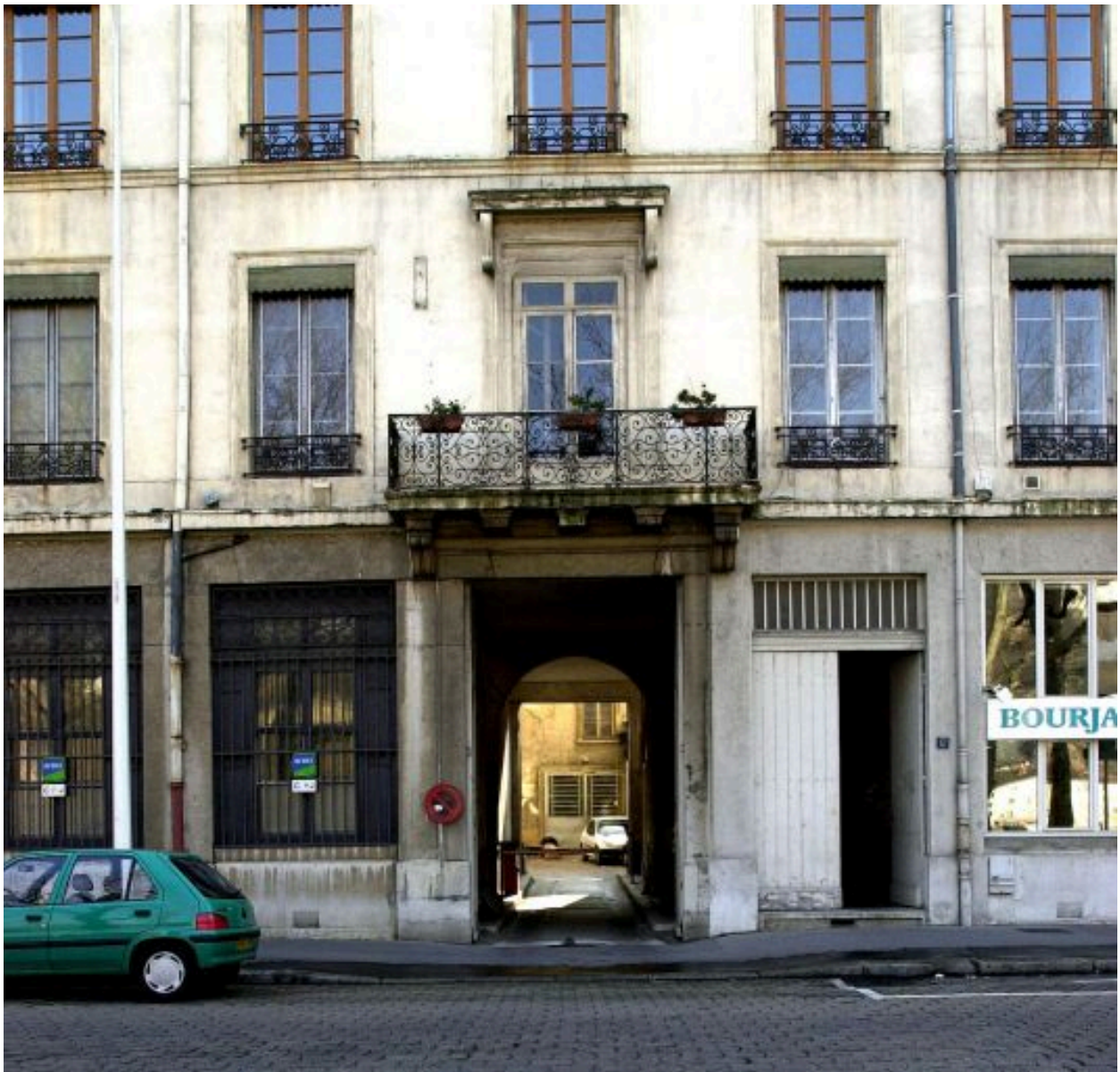
Vue du passage cocher vers la cour et de l'entrée du 12 quai Rimbaud
