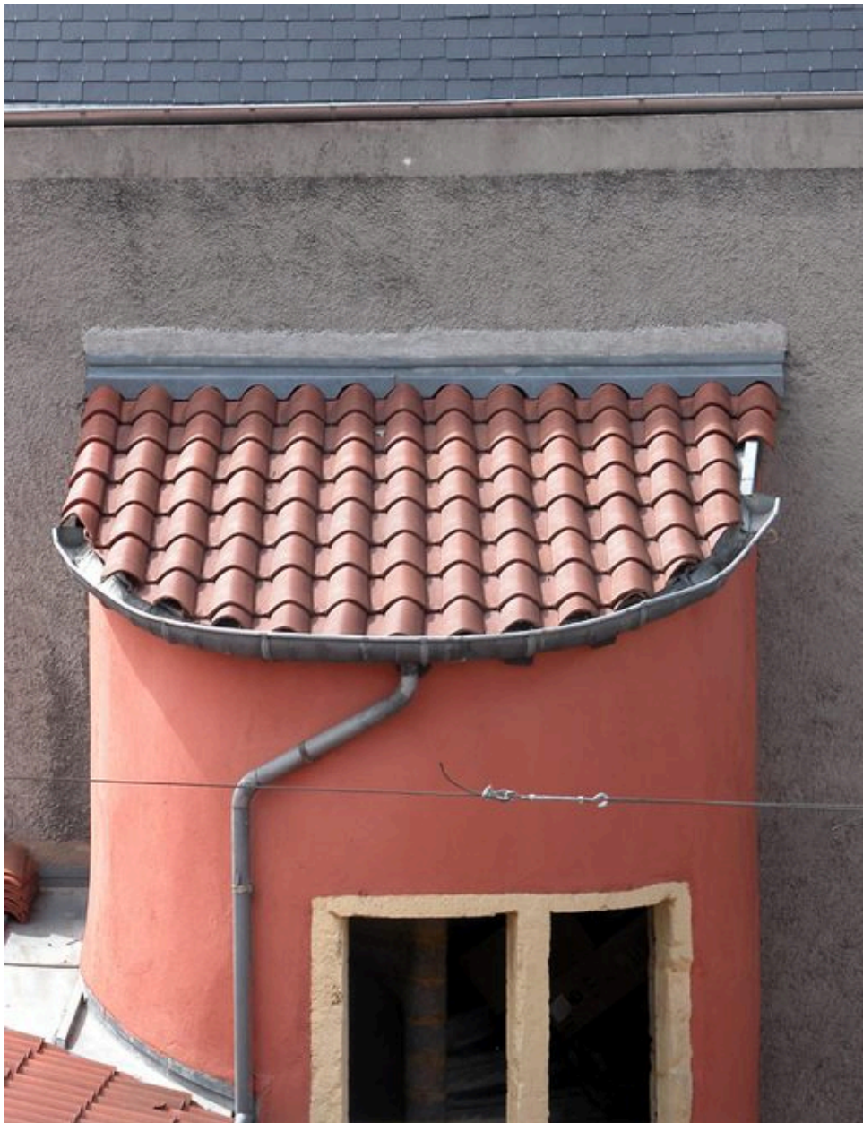
L'étage de guette depuis l'escalier du 42 rue Mercière
