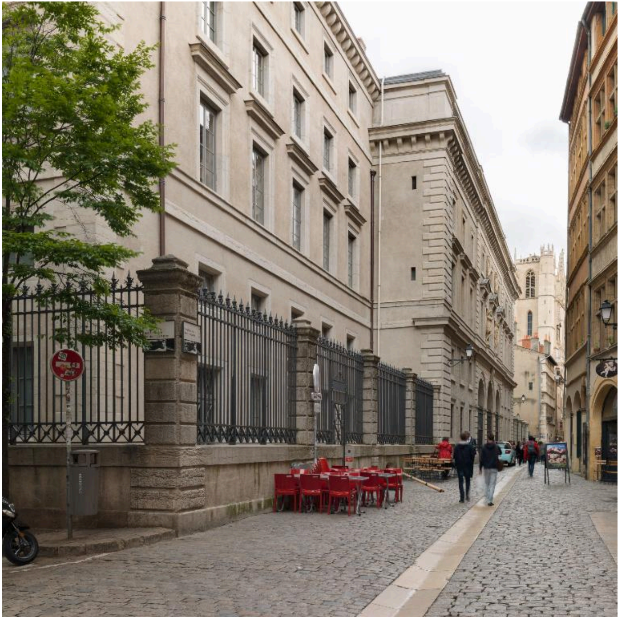
Élévation rue Saint-Jean depuis le nord
