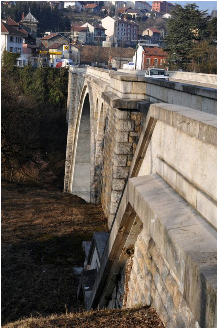
Vue partielle, de côté, escalier de la culée gauche et arche centrale, face aval (depuis la rive gauche)
